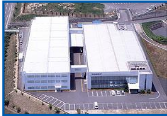
タツモ第1工場
