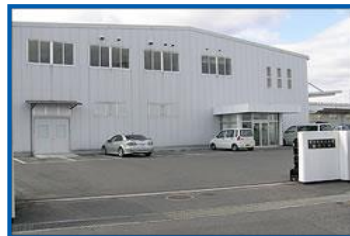
タツモ第5工場
