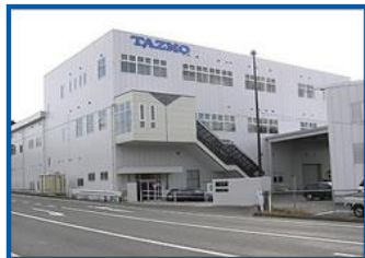
タツモ第3工場
